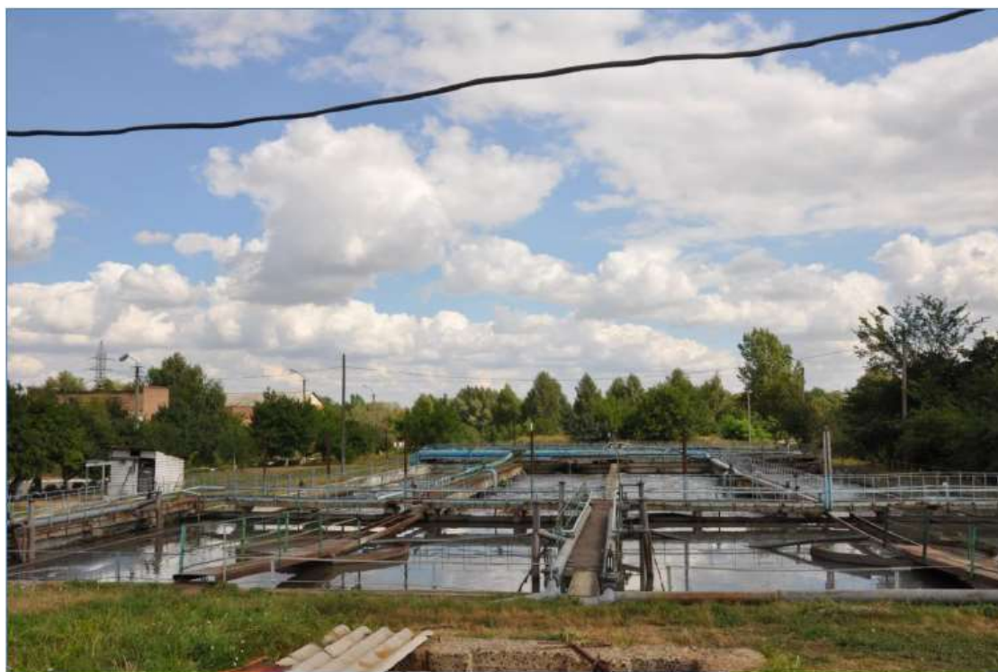
Рис. 1.8 Каналізаційні очисні споруди смт Квасилів
