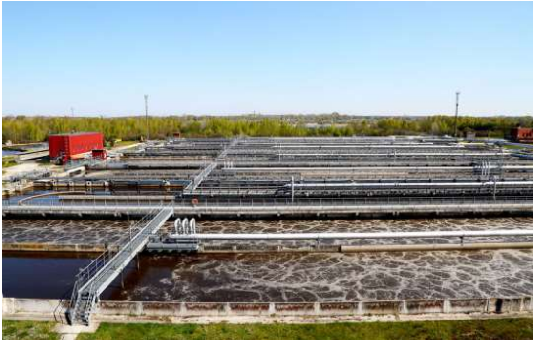
Рис. 2.6 Циркуляційні біореактори із послідовно розташованими аноксидною та аеробною зонами на КОС м. Рига
