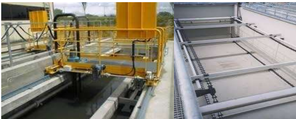
Рис. 2.3. Горизонтальні керовані аеровані піскоуловлювачі
