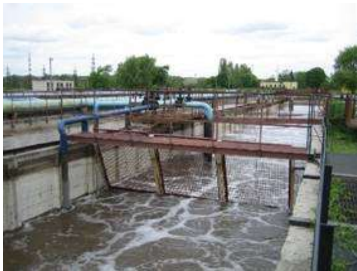
Рис. 2.12 Зонування завантаження в об'ємі біоспруд за допомогою сітчастих пристроїв на реконструйовані коридорних біореакторах КОС в м. Чернігові
