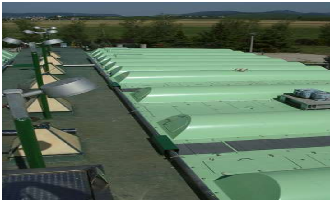
Рис. 2.17 Предварительное осаждение, отбор сырого ила
