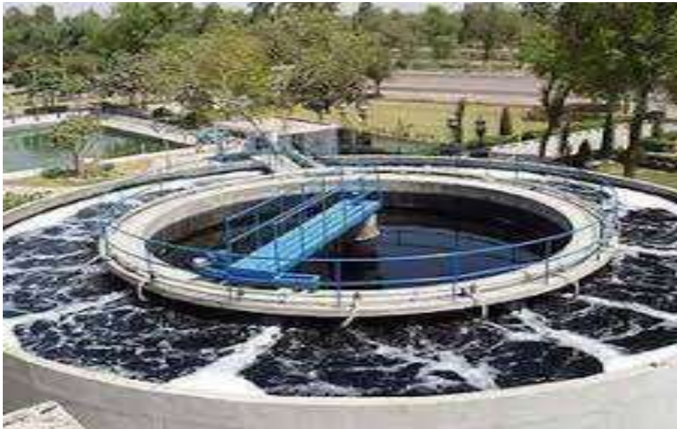
Рис. 2.5 Комбінована споруда із циркуляційним біореактором та коаксіально вбудованим по центру радіальним вторинним відстійником
