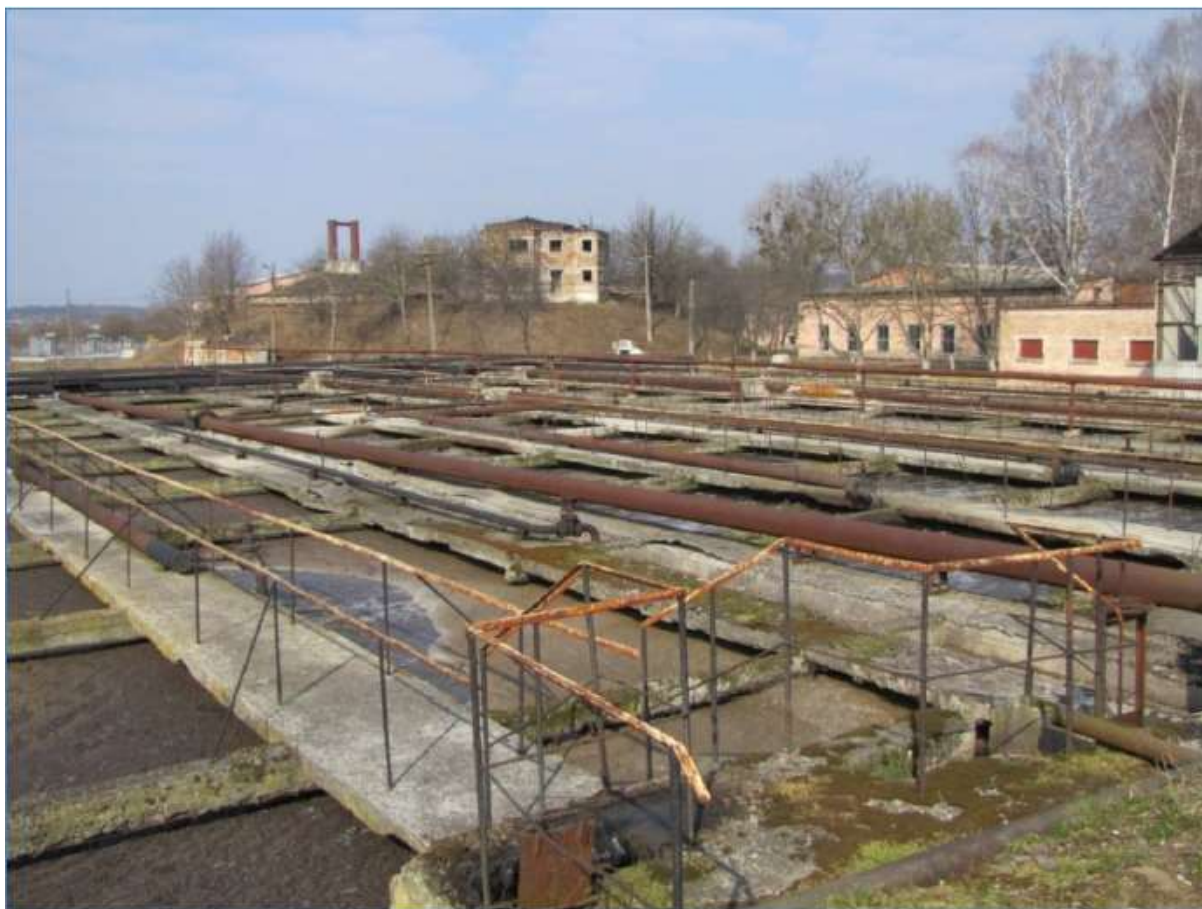
Рис. 1.6 Каналізаційні очисні споруди м. Рівне
