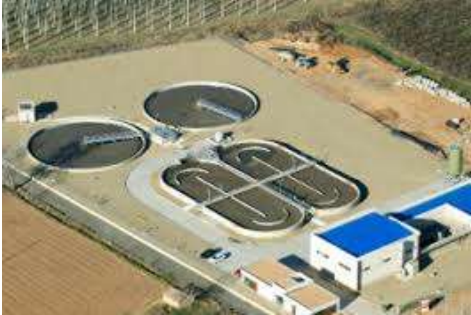
Рис. 2.4 Біореактори з прямокутними коридорами та з окремо розташованими радіальними вторинними відстійниками
