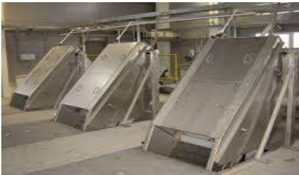
Рис. 2.2. Двоступінчасті механізовані решітки тонкої очистки
