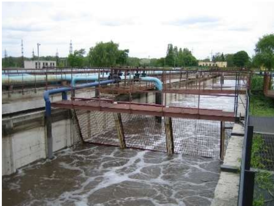
Рис. 2.8 Реконструйовані коридорні біореактори на КОС в м. Чернігові
