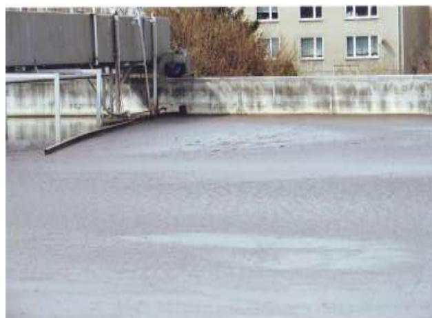
Рис. 2.14 Біотехнологія нітри-денітрифікації. Вторинний відстійник: шар відмерлих часточок мулу на поверхні води (м. Бранденбург)
